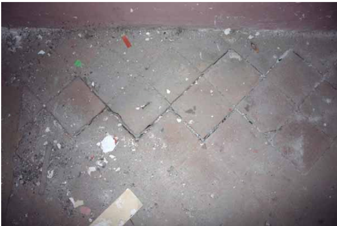
Detall paviment sala 9
