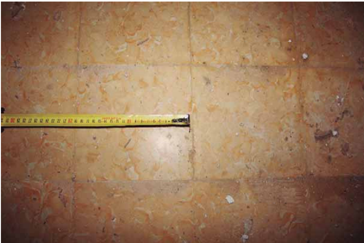
Detall paviment sala 8
